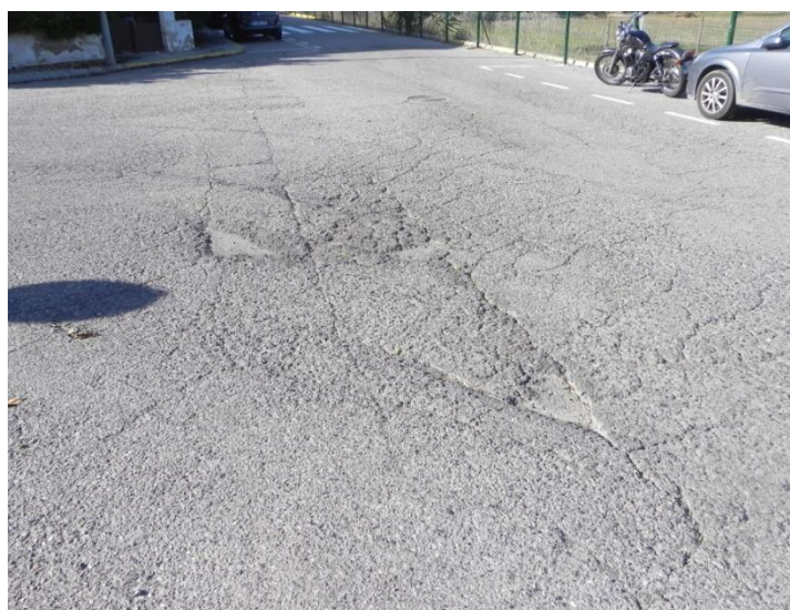
Imagen 9. Presencia de grietas y parches en la calzada del PI Moncada II
