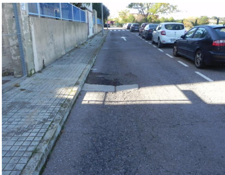
Imagen 9. Presencia de grietas y parches en la calzada del PI Moncada II
