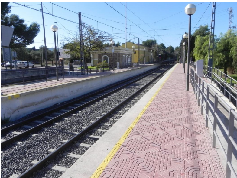
Imagen 6. Estación de metro Masies (Moncada)
