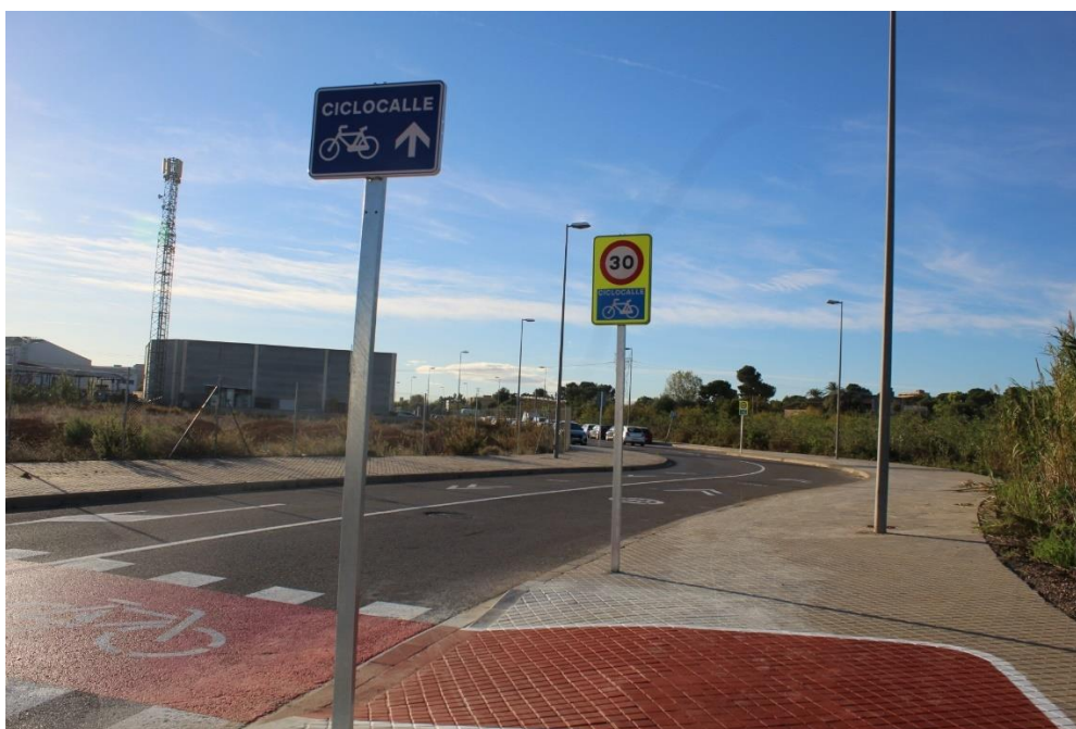
Imagen 15. Acerado con anchura suficiente y en buen estado
