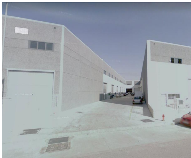
Imagen 22. Acceso entrada calle Ferrers
