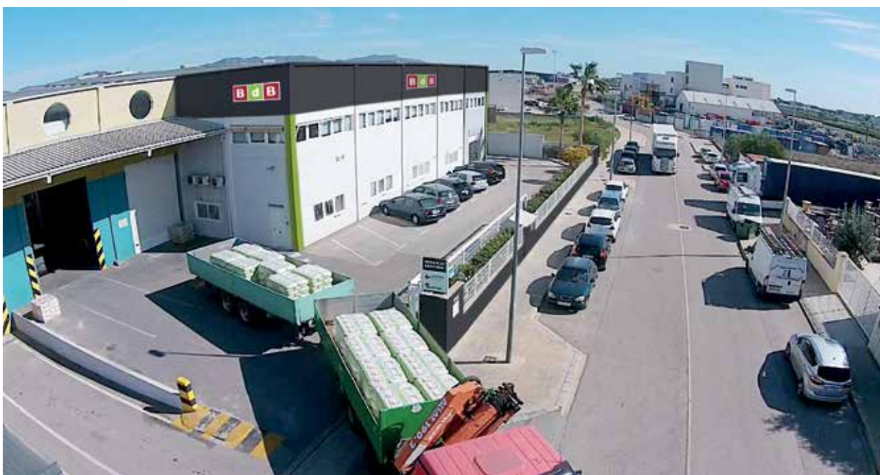
Centro Logístico y oficinas centrales del Grupo BdB en el Polígono Industrial Los Vientos (Náquera)
