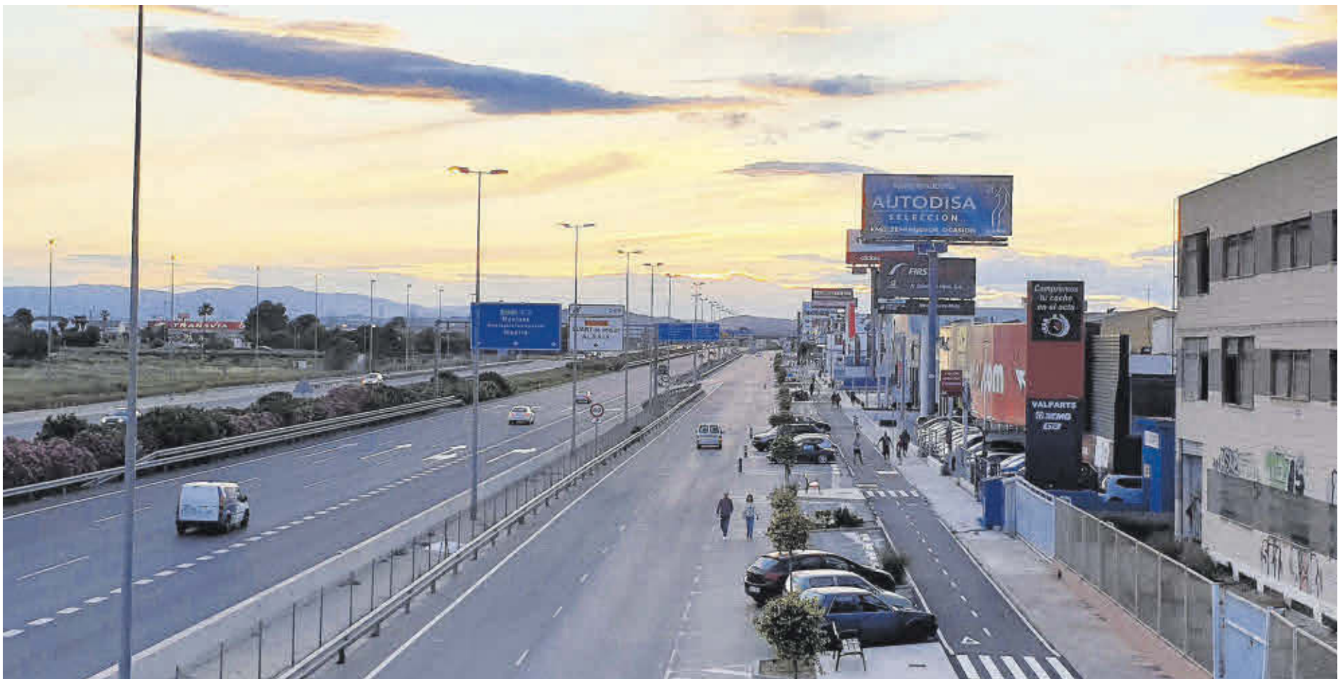
Los principales daños ocasionados por la dana son la destrucción de señalización, de vallados, alumbrado, cerramientos o las instalaciones de drenaje. | A. Q. P.
