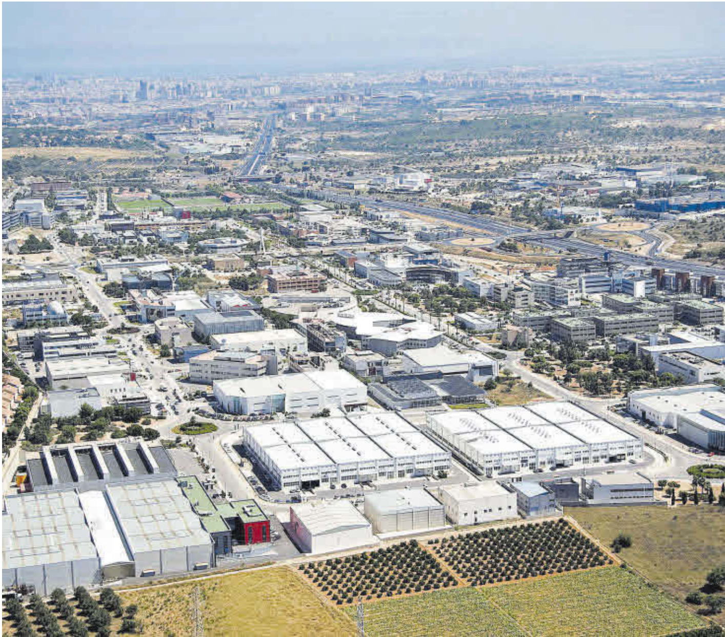
Imagen aérea de las instalaciones del Parque Tecnológico de Paterna. | L-EMV
